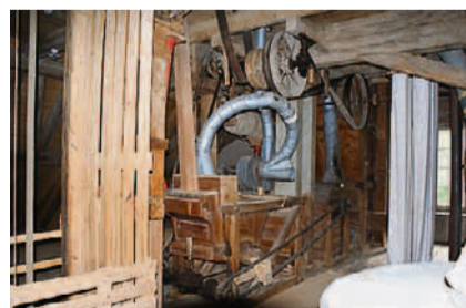
Teil der Anlage im zweiten Stockwerk
