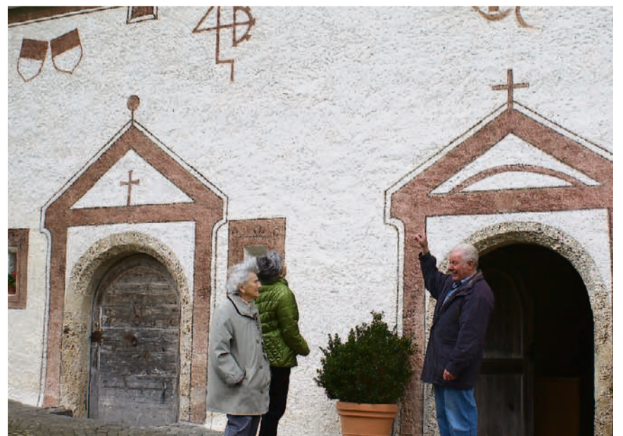
Paul Fluri erklärt, was bei der Fassadenrenovation alles zum Vorschein kam.
